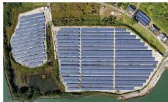
田布施第1・第2発電所 システム容量:3,873Kw
