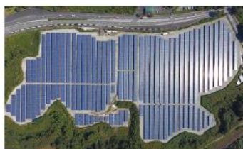
山陽小野田第1・第2発電所 システム容量:5,333Kw
