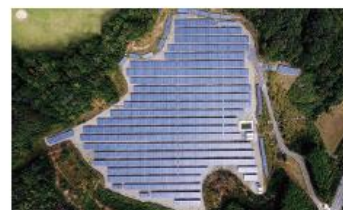
植生第1・第2発電所 システム容量:2,588Kw
